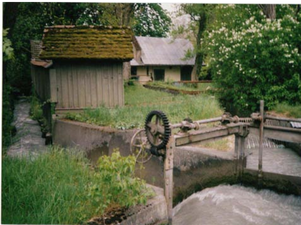
Das weit verzweigte Wassersystem mit regulierbaren Fallen
